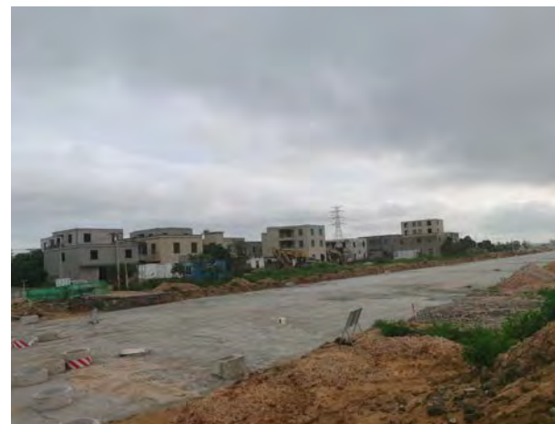
利柏特二期厂区南面：港南大道（在建）
