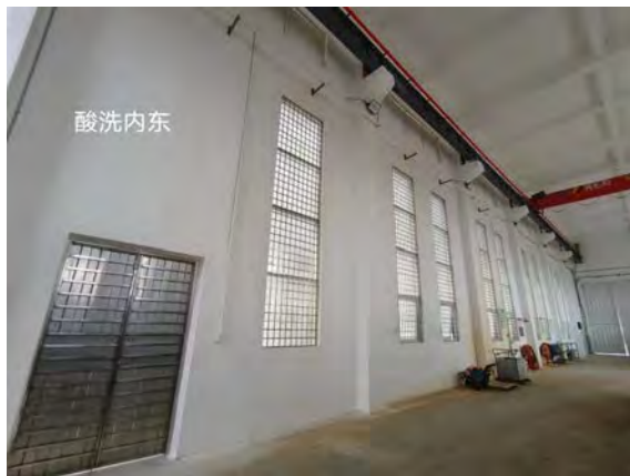
本项目酸洗间现状
